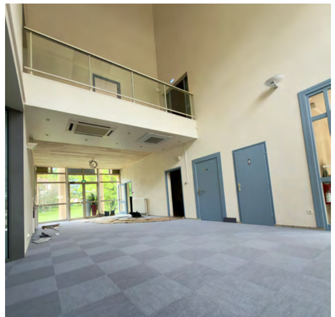
Murs repeints, nouveau sol posé, mezzanine aménagée... il ne manque plus qu'à poser le nouveau guichet d'accueil !
